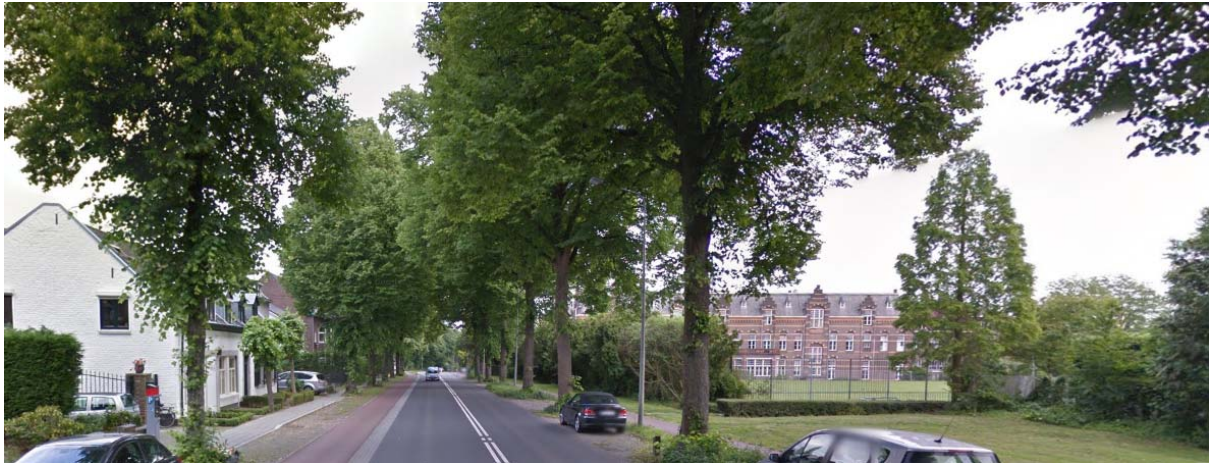
Figuur 8. Zicht vanaf de Tongerseweg, westzijde (bron: Google Streetview).
