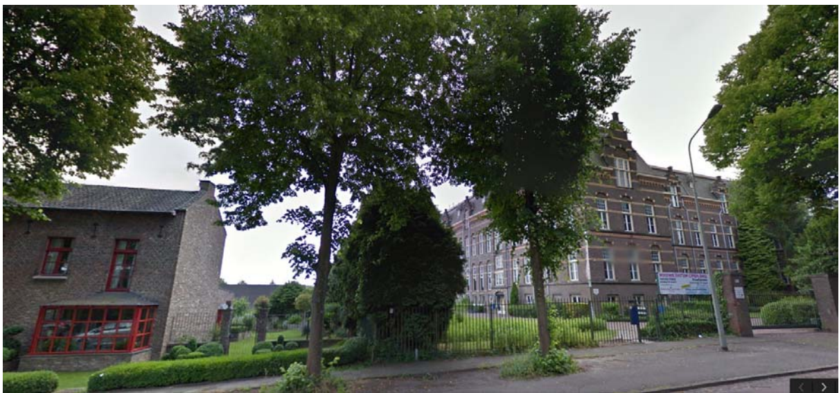
Figuur 9. Zicht op het gebouw vanaf de Tongerseweg, oostzijde (bron: Google Maps)
